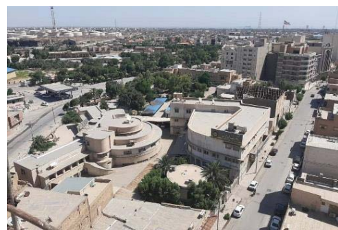
شکل ۲- ساختمان بانک ملی مرکزی آبادان
