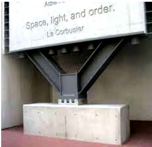
شکل (۲): دیوارهای برشی دارای حرکت گهواره‌ای در دانشگاه تی‌آی‌تی در پژوهش وادا و همکاران [۱۲].
