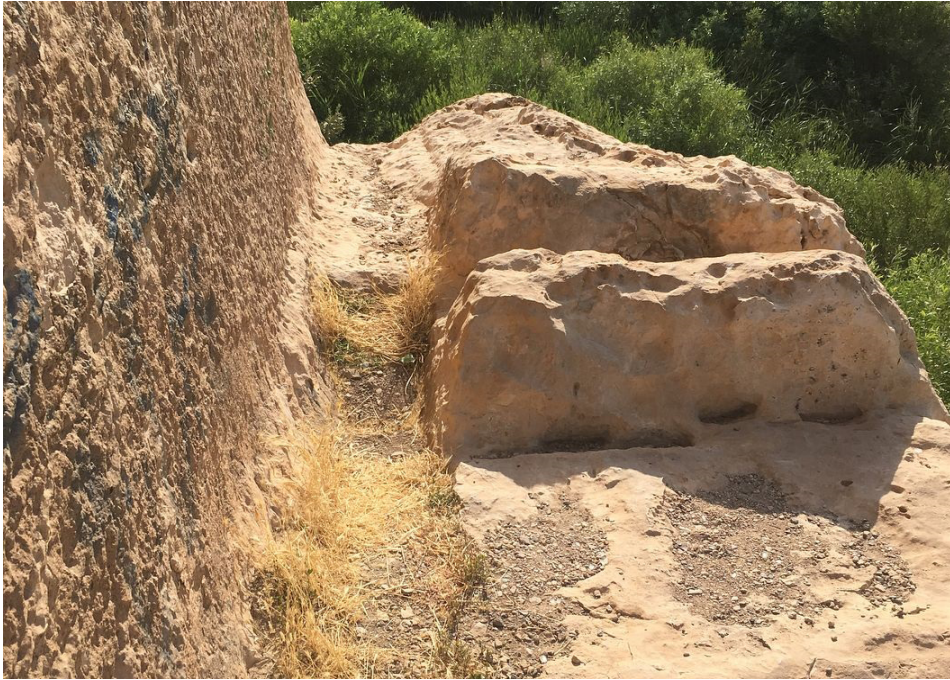
تصویر ۲۱. چاله و شیار حجاری برای زدودن بخش‌های سست بخش جنوبی سان‌روسسم.
