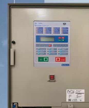
تابلو کنترلر اتوریکلورر ۲۰ کیلو ولت مدل: BR-10RN
