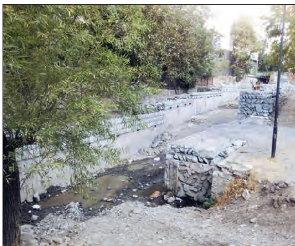
نمایی از اقدامات کانال‌سازی رودخانه دارآباد، ۱۳۹۵
