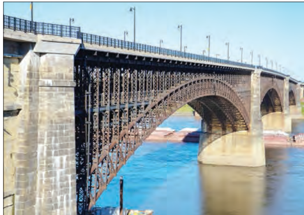
پل ایدز روی رودخانه می‌سی‌سی‌پی که با فولاد کارنگی ساخته شد
