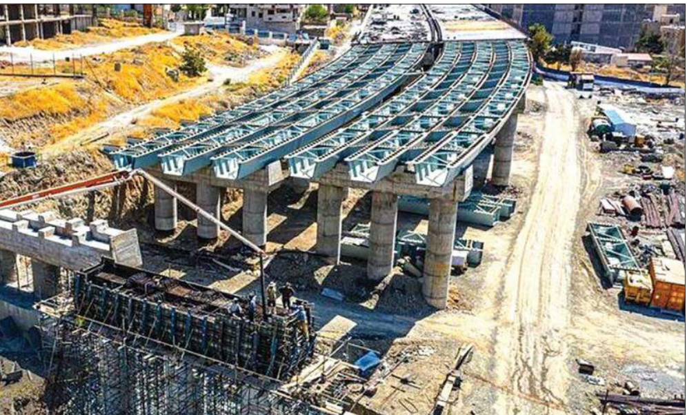
پروژه آزادراه شمالی کرج
