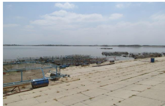
شکل ۲: مرحله‌ی تکمیل ساخت قفس‌ها در سد گلستان
