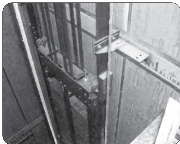
شکل (11): وزنه تعادل و تسمه‌های اتیس
