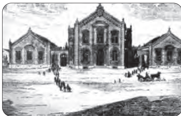
منظره‌ای از فامیلیستر گودن ساختمان مهد کودک چسبیده به قسمت مرکزی ساختمان کاخ اجتماعی است.
