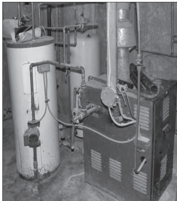
◀ شکل (28): اتصال به شیر گاز
