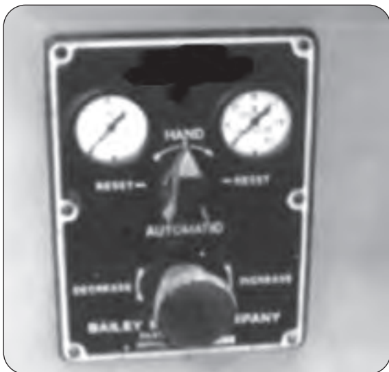
شکل (11): پانل پنوماتیکی H/A قدیمی
