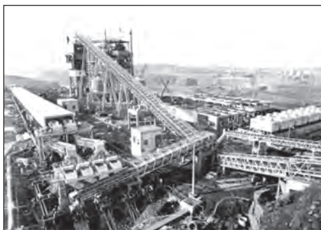
تصویر (10): پیش‌سرد کردن مواد برای بتن‌سازی در یک سد
