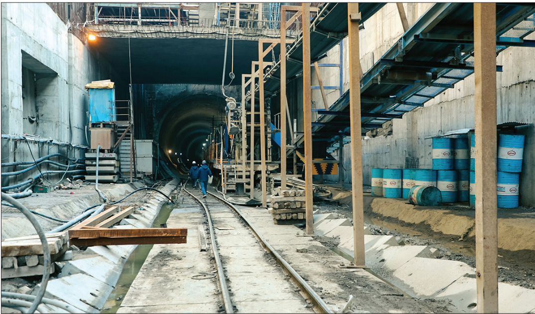
تکمیل عملیات ساختگاز خیام
