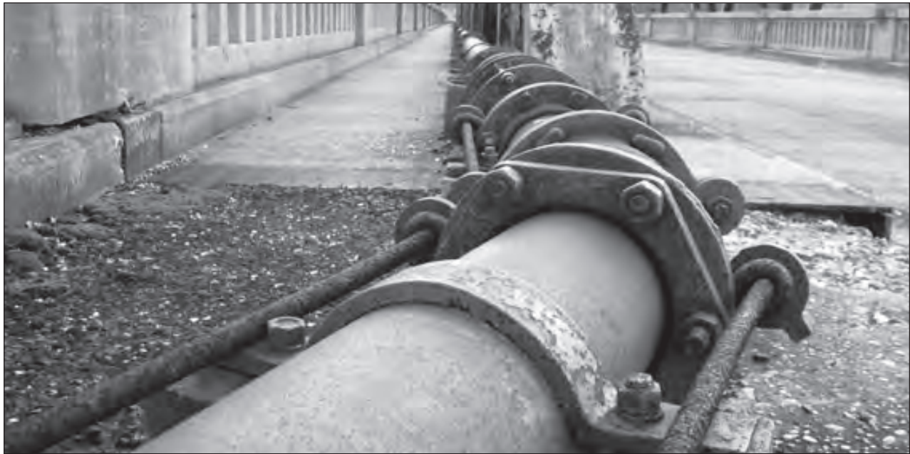
لولہ کشی سیستم های بخار 3psig - لولہ فولادی (ادامہ)
