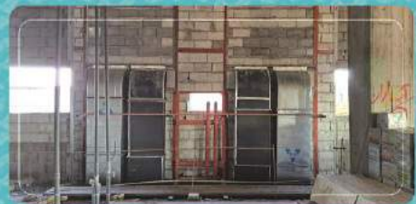
تکمیل اجرای کانال‌های هوارسان بونکرها
