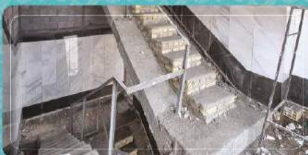
اجرای سنگ دیواره‌های پلکان
