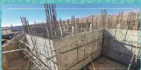
تکمیل بتن‌ریزی دیوار برشی و ستون‌های زیرزمین زون مرکزی و باز نمودن قالب‌ها
