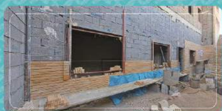
اجرای نمای شمالی زون شرقی
