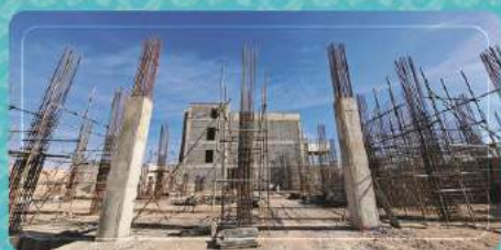
اجرای داربست و آرماتوربندی ستون‌های زون مرکزی
