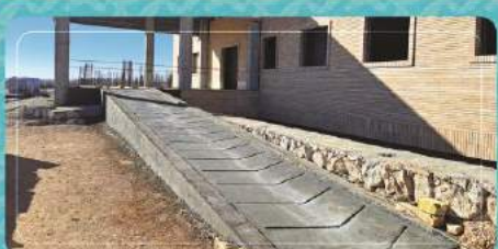
اجرای رمپ ورودی زون شرقی ضلع جنوبی
