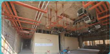
ادامه اجرای تأسیسات مکانیکی زون شرقی
