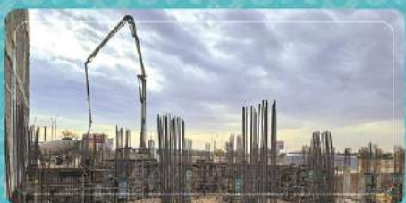
بتن‌ریزی دیواربرشی ضلع جنوبی و ستون‌های زیرزمین زون مرکزی مرحله اول
