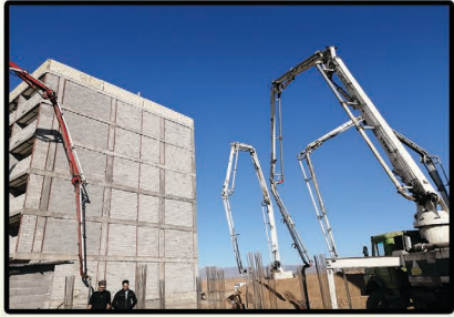
250 مترمکعب بتن فنداسیون در 75 دقیقه - ساوه
